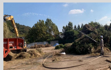
破碎作業での防塵散水
